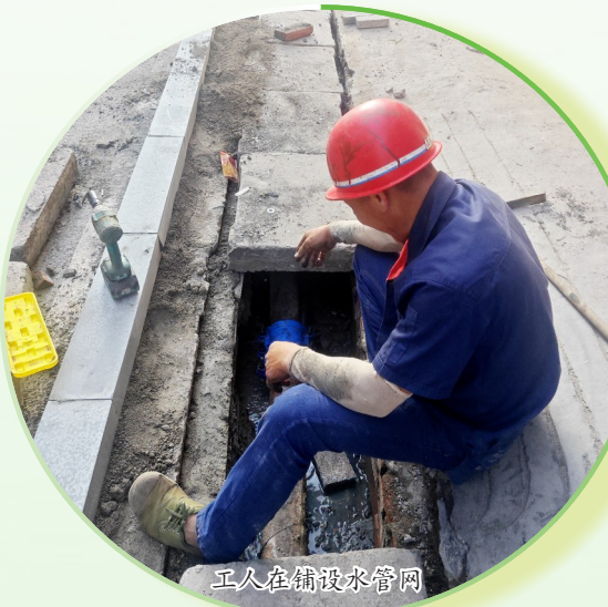
工人在铺设水管网
